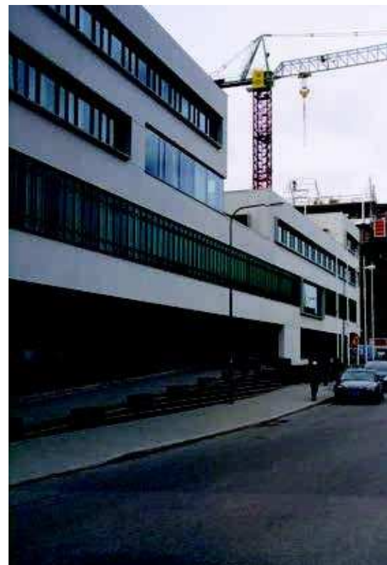
För att inte bli för skarp bör en vit fasad vara lite tonad mot gult och grått. Observera att flaggstängerna är ljusare än fasaden – som vi ändå upplever som vit. Försvarshögskolan/Utrikespolitiska Institutet intill KTH Campus i Stockholm ritad av Berg Arkitekter och färdigställd 2005.
