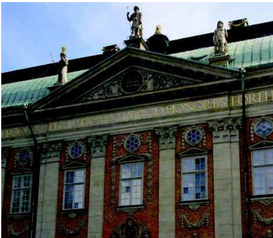
Riddarhuset (färdigt 1674) var liksom de flesta av dåtidens tegelbyggnader ursprungligen struket med röd kalkfärg för att förstärka den röda tegelfärgen. De röda murarna stod i stark kontrast mot de huggna stendetaljerna, som var målade med "stenfärgad" oljefärg.
