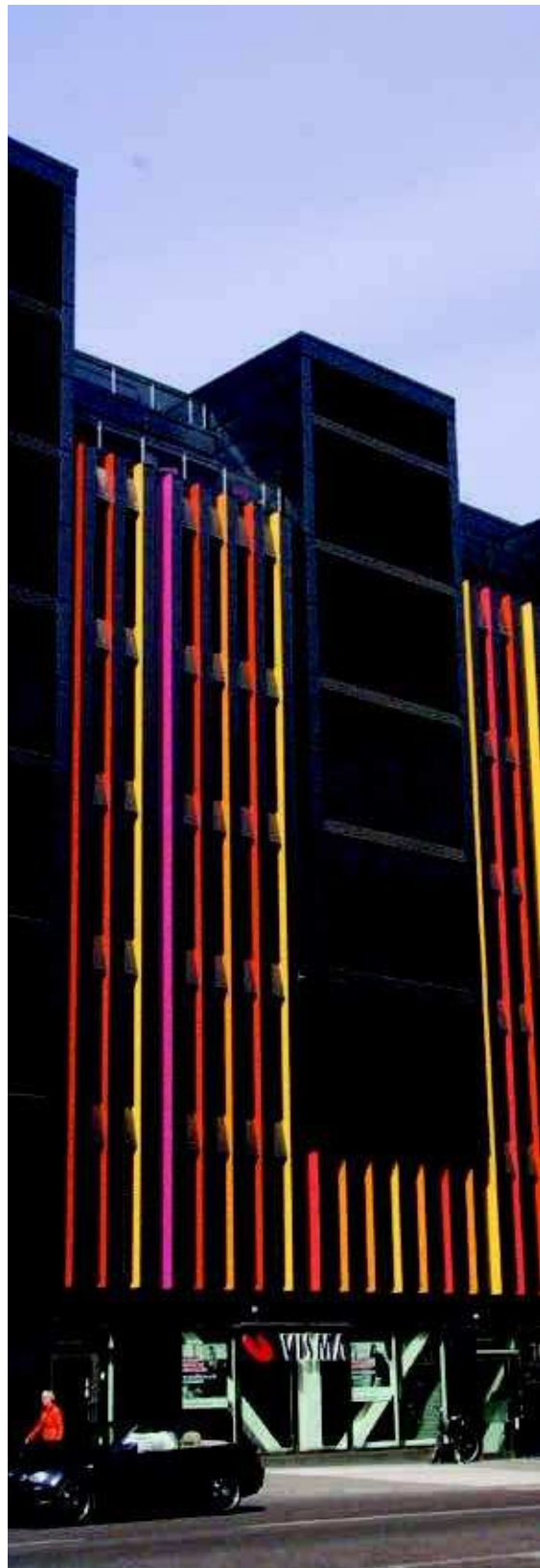
Ny teknik ger nya möjligheter. En såhär färgstark färgsättning skulle inte ha varit tekniskt möjlig för sextio år sedan. Kungsbron, Kv. Mentorn 1 i Stockholm, ritat av Wester + Elsner Arkitekter och färdigställt 2009.
