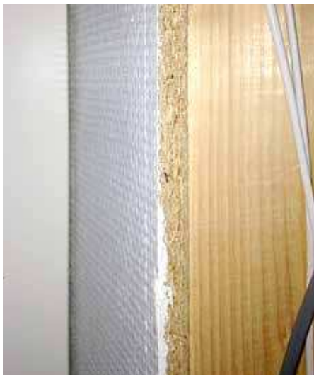
Träyttskikt på vägg är tillåtet i byggnadsklass Br2 och Br3, men normalt inte i klass Br1.
