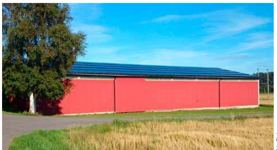
Figur 3. Solcellsanläggning på ett lutande tak på en lantbruksbyggnad.
