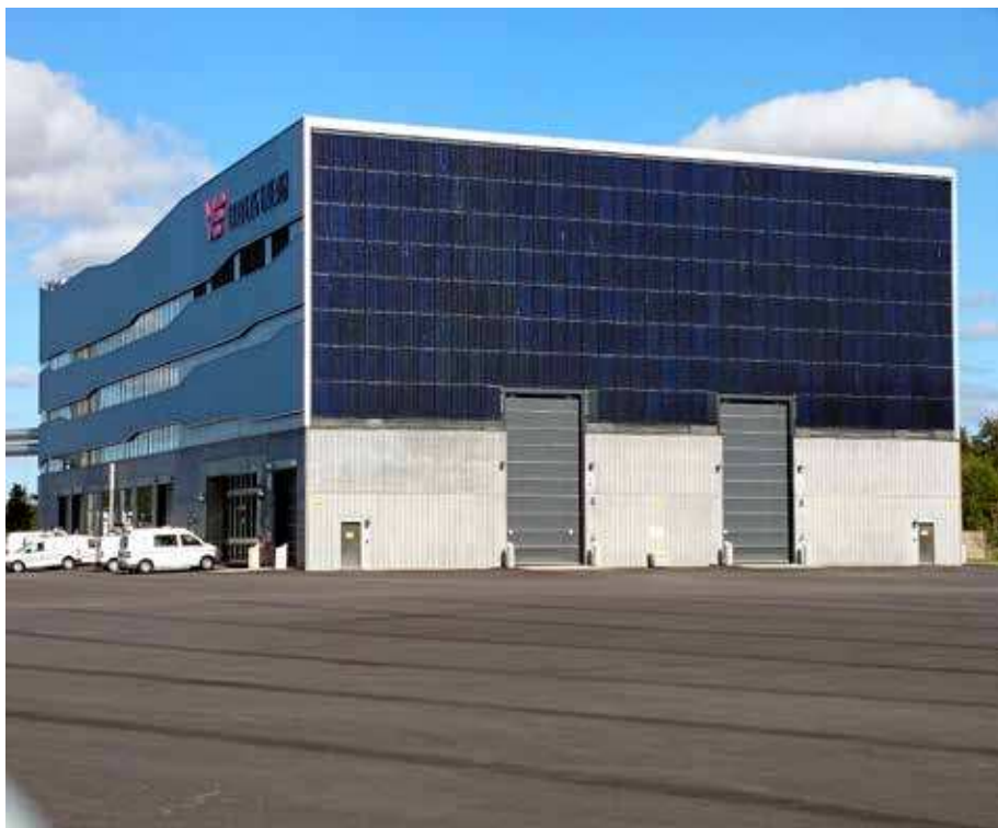
Figur 6. Solceller på fasaden på Varberg Energis värmecentral.
