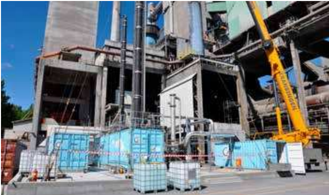
Pilotförsök av koldioxidavskiljning hos Norcem AS i Bervik, Norge.
