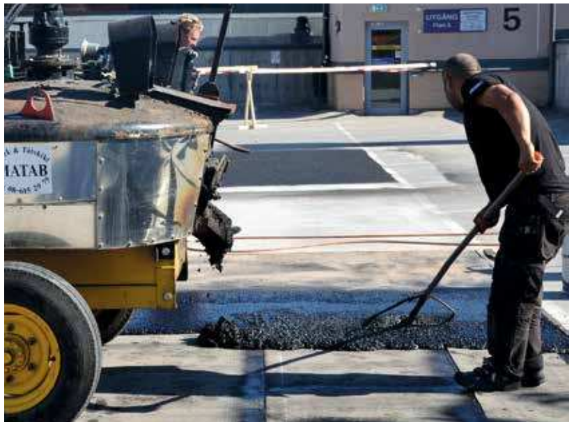
Baggen – Gjutafalt på tätskiktsmatta läggs ut.
