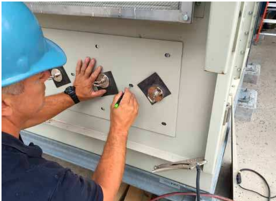
Bild 7. Markering för svetsbultar.
