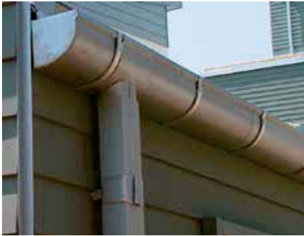
Bild 2. För hängrännor som inte är halvrunderna kan uppgifterna om ungefärlig vattenförande area användas i tabell RA JT-.811/1.
