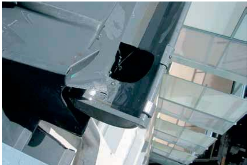
Bild 6. Hål i hängränna måste ha minst samma diameter som stuprör. Kant i hål ska drivas ner något.
