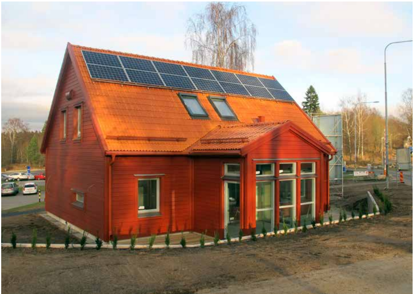
Figur 1. Den energieffektiva villa som uppfördes på RISE område i Borås år 2013 och där boendesprinkler installerades som ett led i att demonstrera tekniken.
