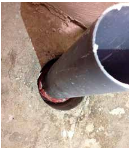
Ett bra betongbjälklag med pågående rörintallationer och tillhörande "brandstrypare".
