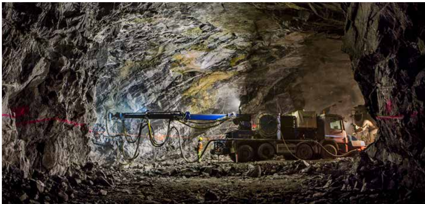
I Vinsta har arbetet med att bygga eldriftsutrymmen påbörjats.
