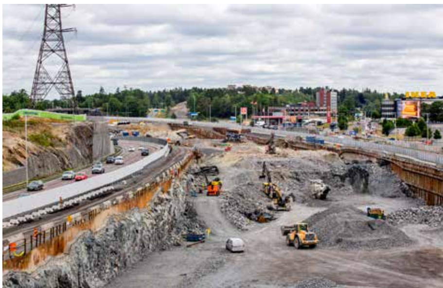
Under 2018 ska arbeten med nya vägar och en ny gång- och cykelbro i Vårby backe i närheten av Kungens Kurva påbörjas.
