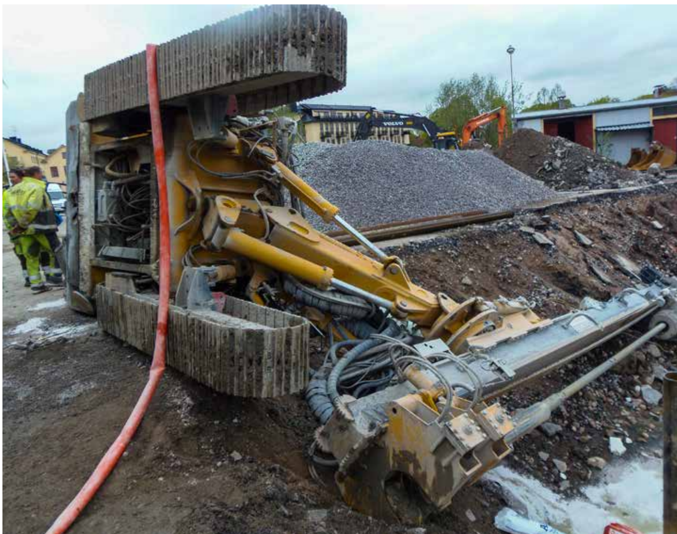
Exploatering kräver noggrann planering och riskanalyser ända från grunden.
