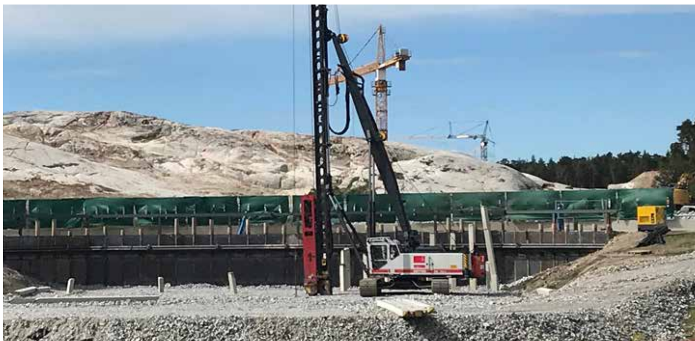
En Arbetsplattform ska hållas intakt under hela grundläggningen.
