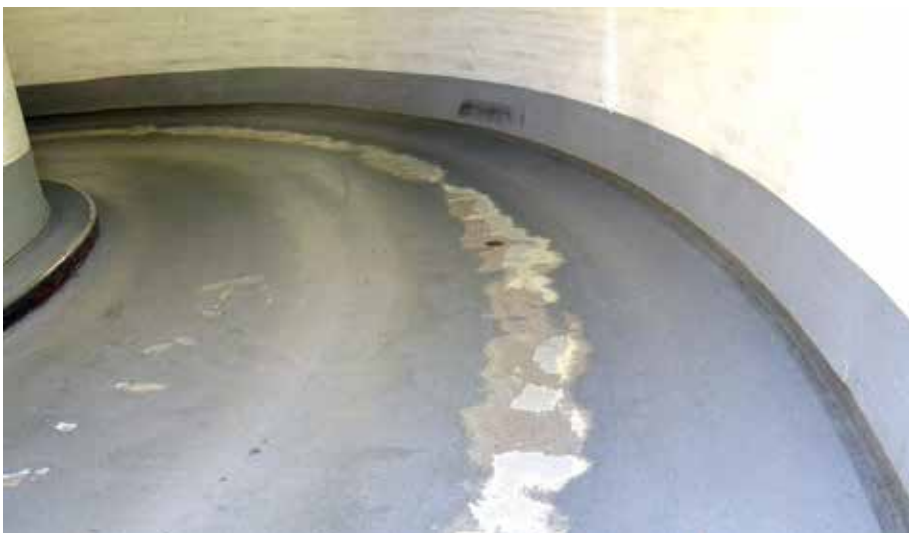
Exempel på skador för beläggningssystem på P-däck – vidhäftningsförlust på köryta och slitage i ramp.
