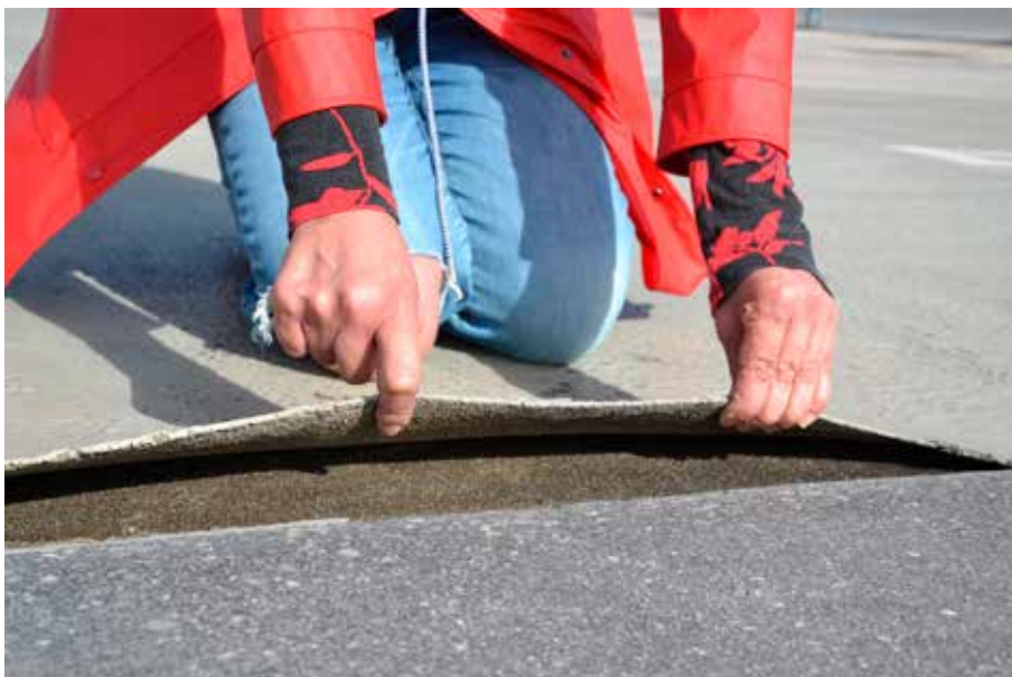
Exempel på skador för beläggningssystem på P-däck – vidhäftningsförlust på köryta och slitage i ramp.
