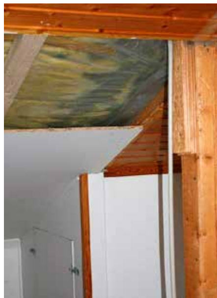
Figur 2. I taket på en trevånings 70-talsvilla har damm deponerats under många år vilket givit en tydlig indikation på hur luften har rört sig.
