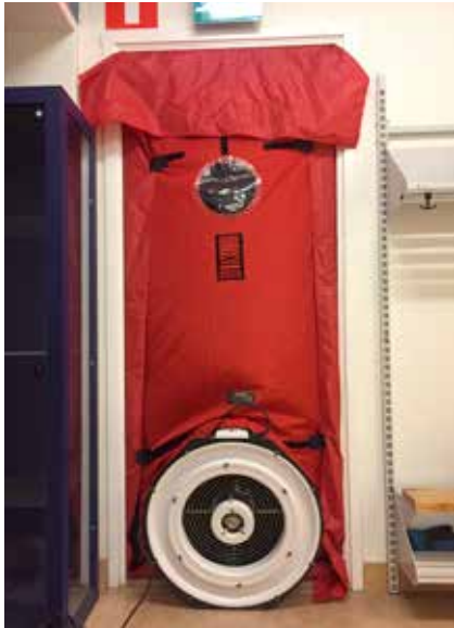
Figur 4. Med hjälp av en Blower door i en ytterdörr så sugts luften ut ur byggnaden och ett undertryck skapas.
