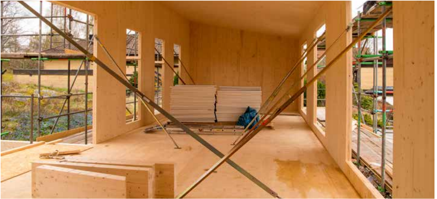
Stommen monterades med hjälp av kranbil. Sedan skruvades de olika blocken ihop.
