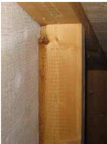
Bild 5: Svarta prickar av mikrobiell påväxt på träregelstomme i kontakt med MOC-skiva.
