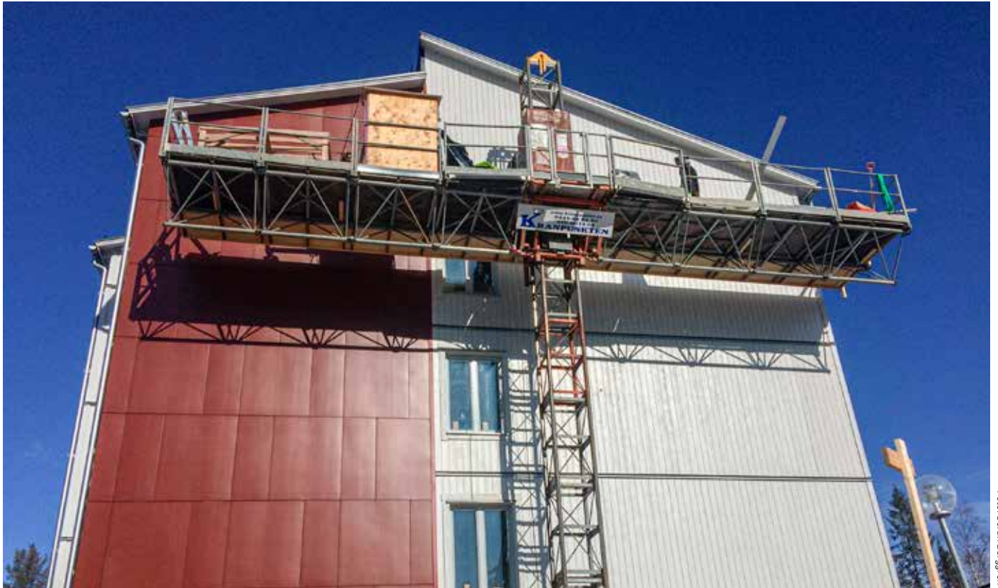
Montage av fasadsystemet från byggplattformen.
