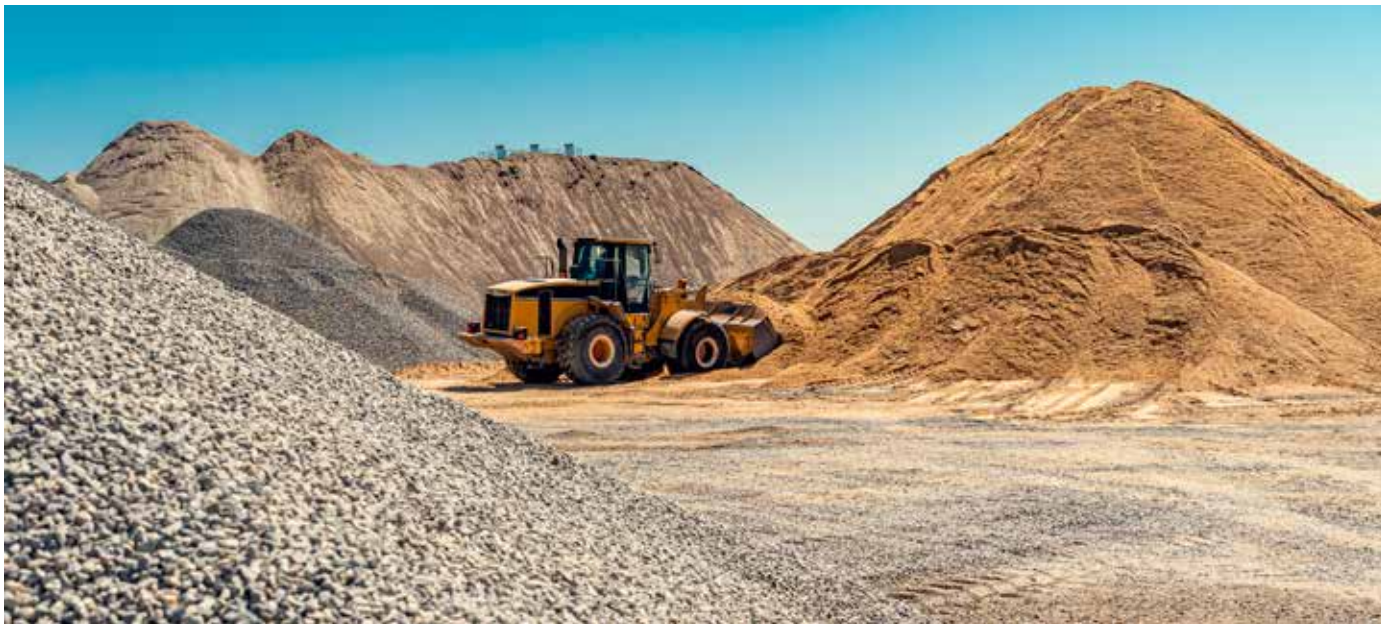
Inom byggprojekt är geotekniska konstruktioner nödvändiga vid bland annat grundläggning, markförstärkning och släntstabilisering, vilka alla har en påverkan på klimatet under sin livscykel.
