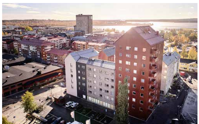
Figur 3. Volymbyggnader med varierande arkitektonisk utformning.
