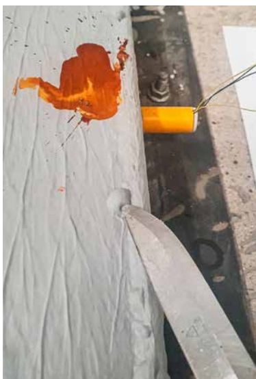
Figur 18. Kondensbubblor tätskitt (rostfärgad på grund av stålram).
