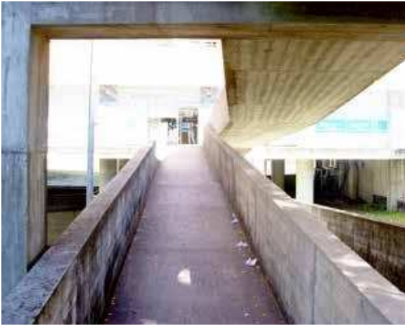
Ramp till gångbro i Guimaraes, Portugal.
