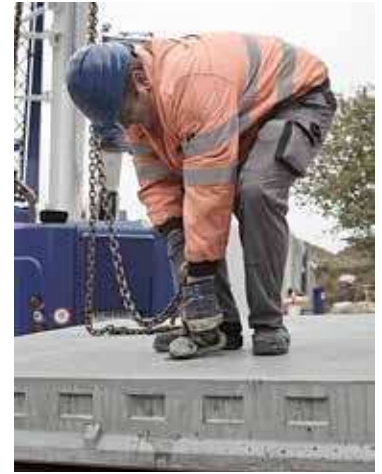
Montage av planelement i superlätt betongkonstruktion.
