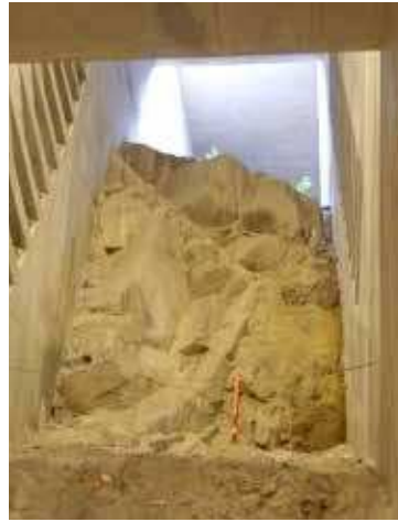
Betongfundament under Estadio Braga, Portugal.
