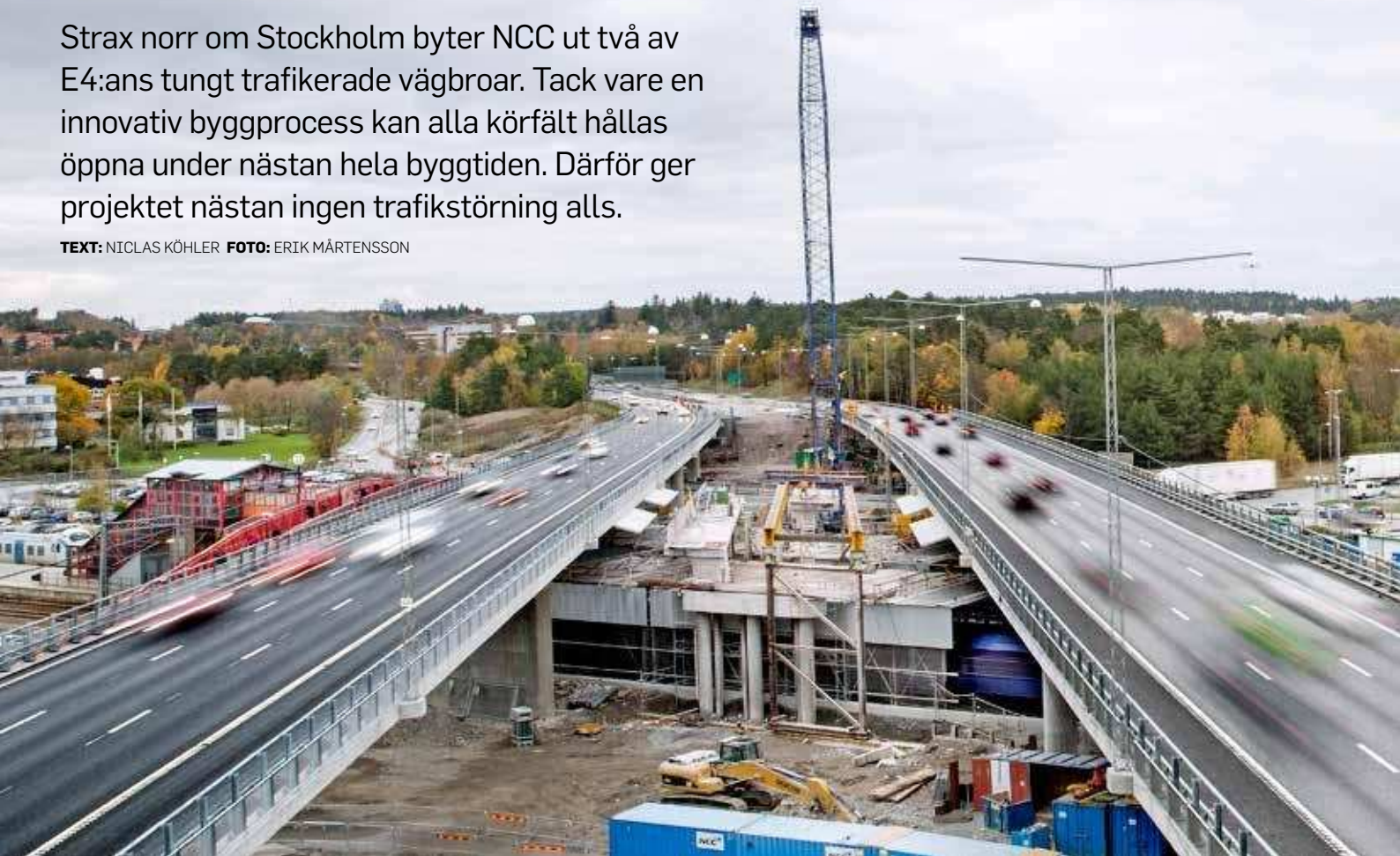
Vecka 28–29 i juli kommer den spännande sidoflyttningen av östra broöverbyggnaden att ske.
