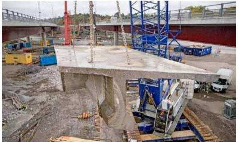
Fem meter långa och 60 ton tunga bitar av den gamla vägbanan lyfts ner.
