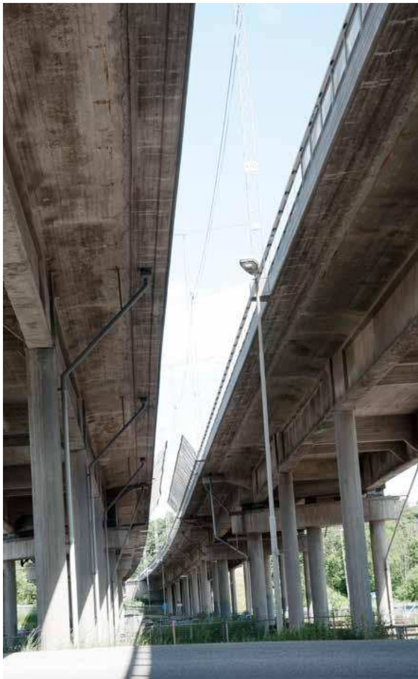
Vägbroarna för fyra körfält byggdes 1962 på 30 klena betongpelare.
