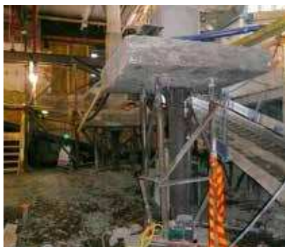
Ny källare under en del av Södra Paviljongen.
