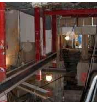
Södra Paviljongen, avlastning av stomme.
