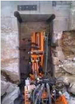
Pålning i nisch, Hus A.
