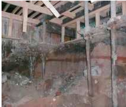
Utgrävningarna och grundförstärkning av Hus B under trapporna till "Hyllan" samt bottenplattan under lokalen där McDonald's ligger.
