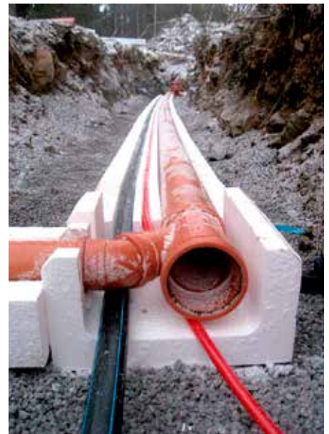
Samförägrning av fjärrvärmenät med vatten och avloppsledningar på cirka 70 cm djup i bostadsområdet där Sjunde huset är byggt.
